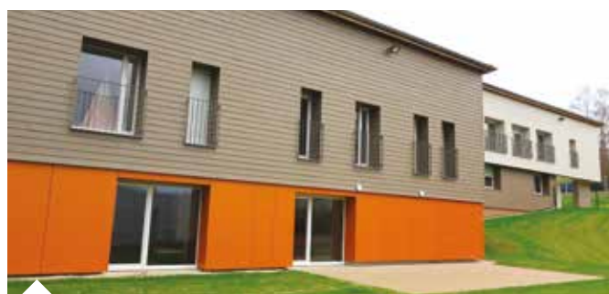
Les deux premières maisons complètement rénovées
